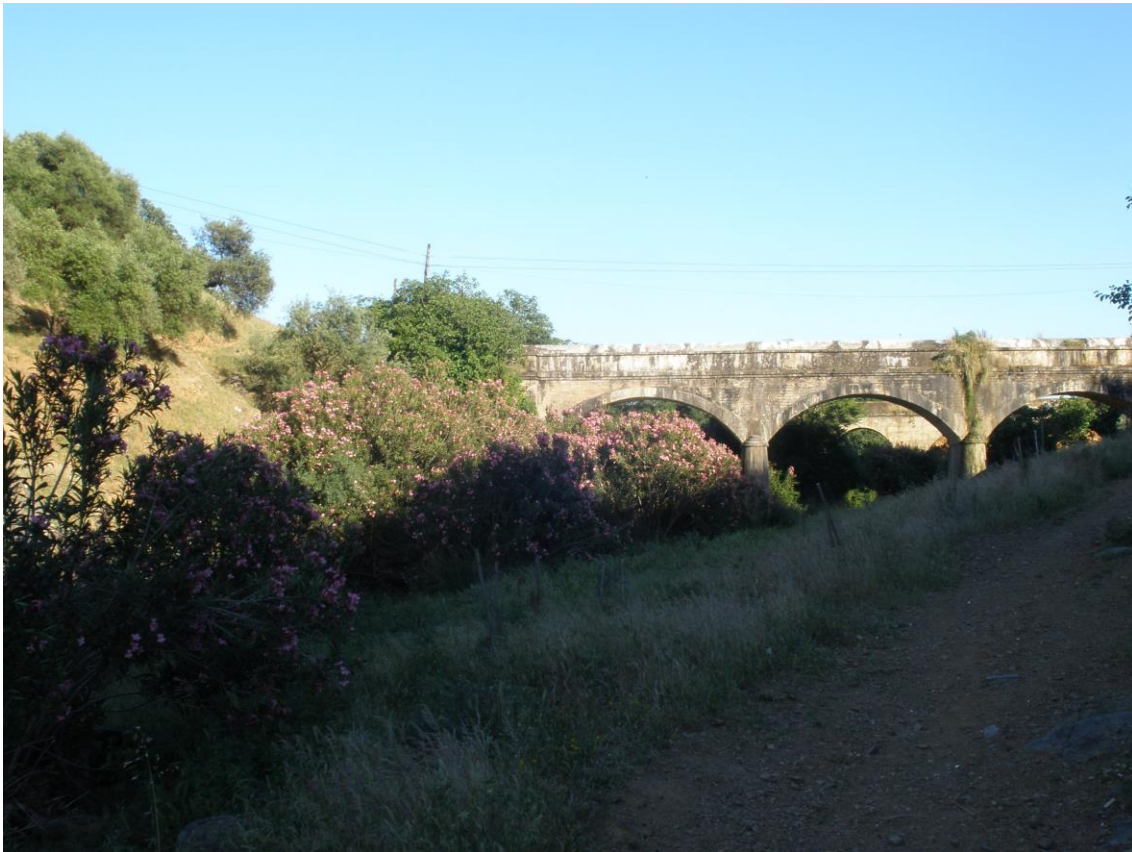
Puente de la Antigua Carretera de Almadén
