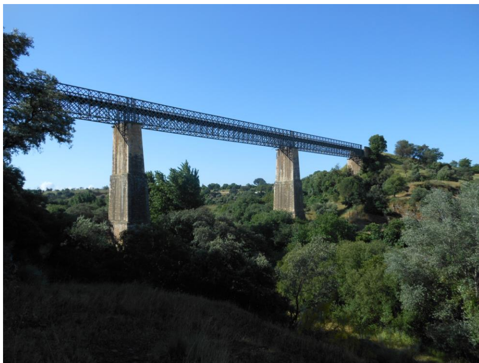
Puente de Hierro, situado sobre la antigua azuda
